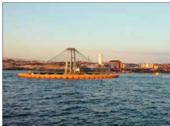
Figure 4.13. Smøla Klekkeri og Settefiskanlegg. Floating semi-closed containment system (Photo: Smøla Klekkeri og Settefiskanlegg)
